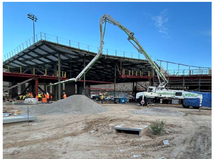
Segment 'B' SOG Concrete Pour
